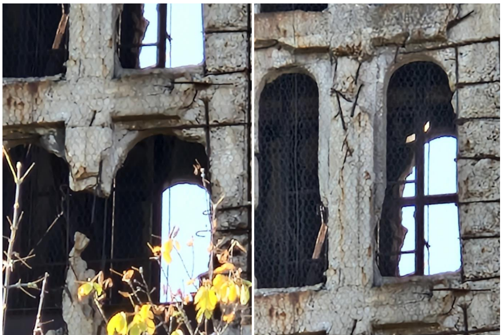
az omlásveszély miatt sűrű fonatú acél védőhálóval van bevonva.
