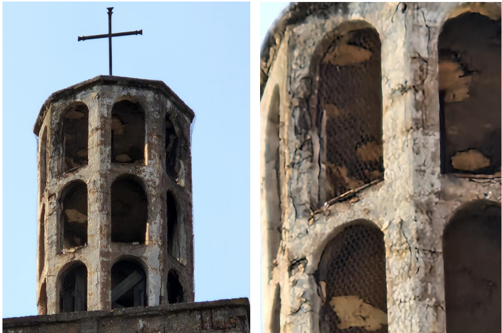
A harangokat befogadó felépítmény szintén kritikus állapotú.
