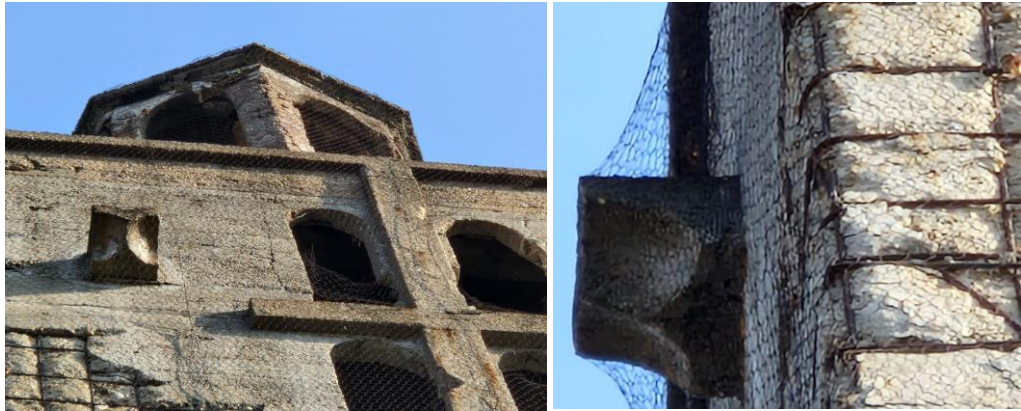
A toronytörzs felső része a pusztulásnak indult kritikus állapotú homlokzattal és falnyílásokkal
