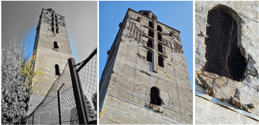
A toronytörzs felső része a pusztulásnak indult kritikus állapotú homlokzattal és falnyílásokkal
